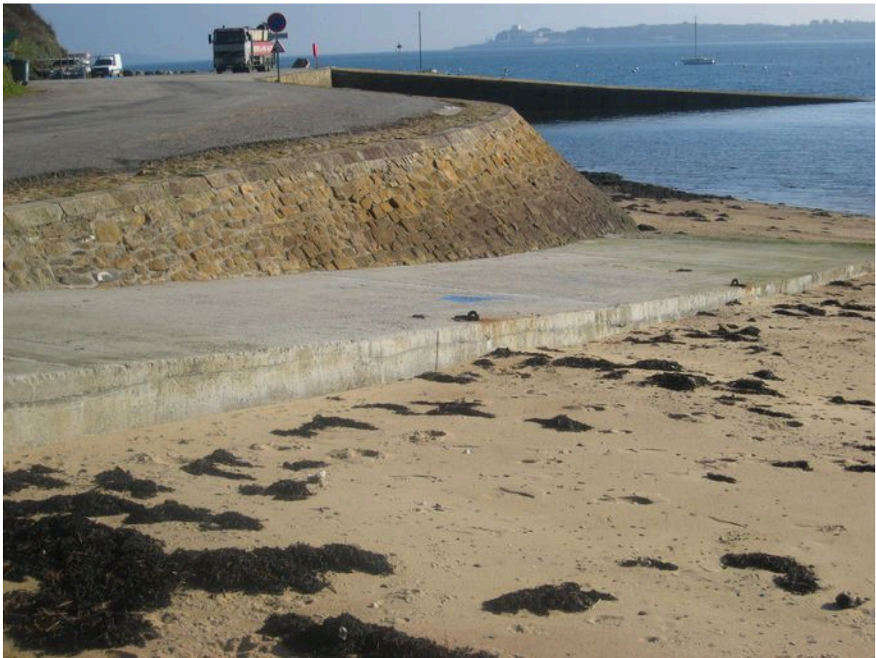
Débarcadère de Roscanvel avec cale récente au premier plan et cale de 1870 à l'arrière-plan
