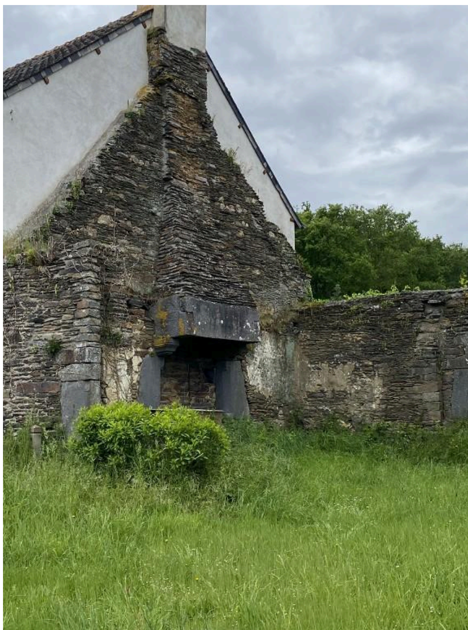
Ancienne cheminée côté ouest.
