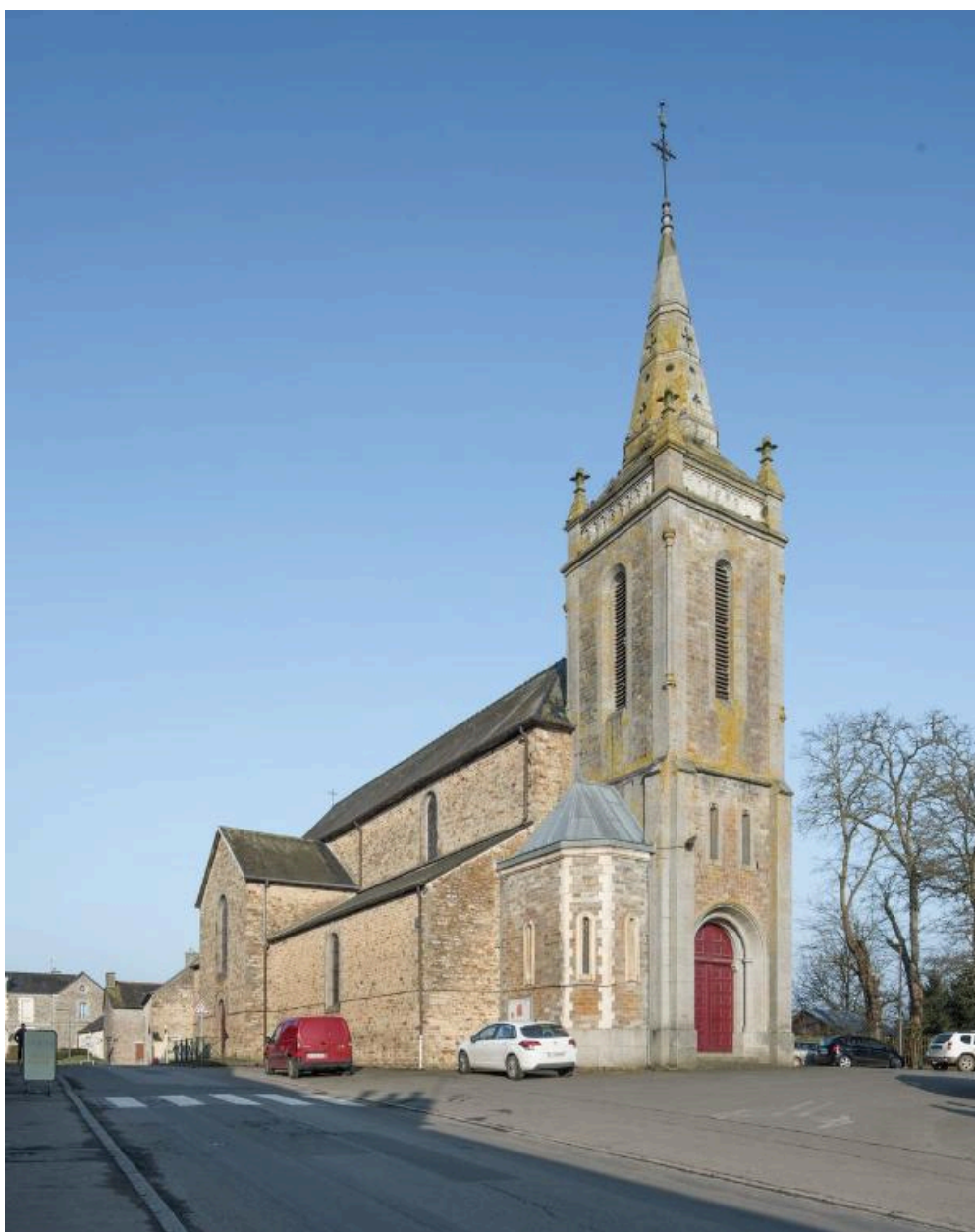
Façade prise du sud-est (état en 2018)
