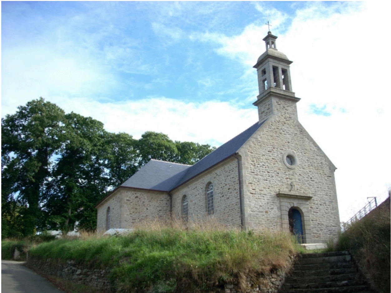
Le Ponthou, église paroissiale Saint-Barthélémy : vue générale nord-ouest
