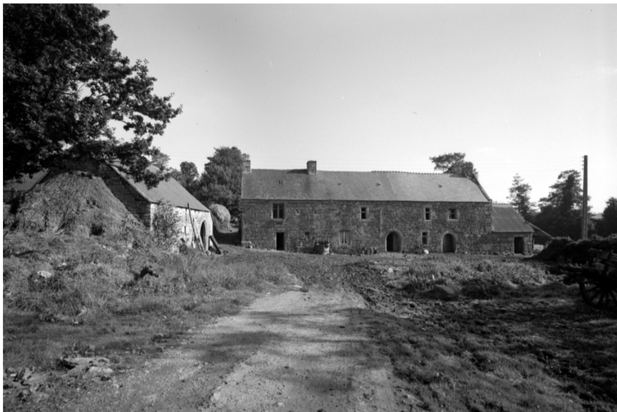
Vue générale de situation
