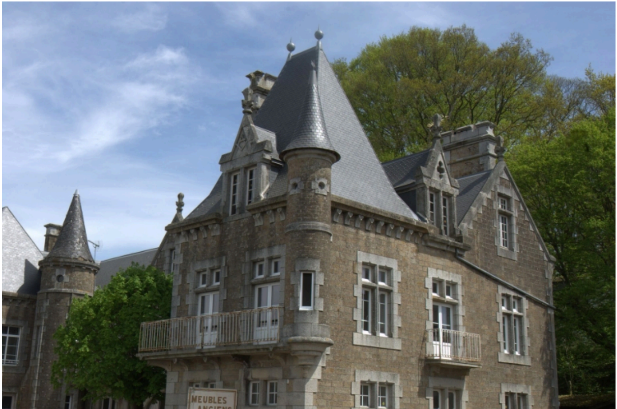
Détail de la façade
