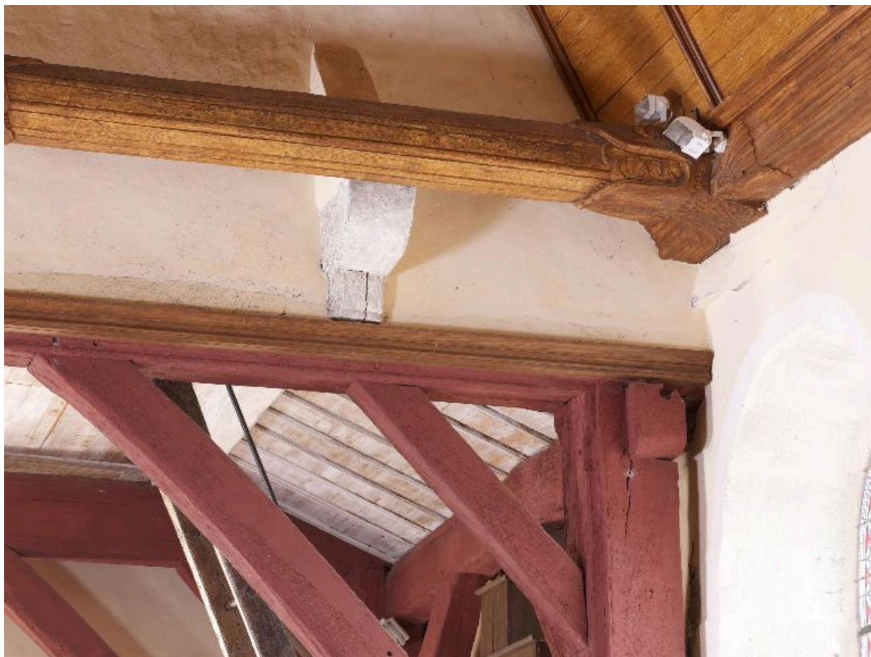
Détail d'un engoulant de la charpente
