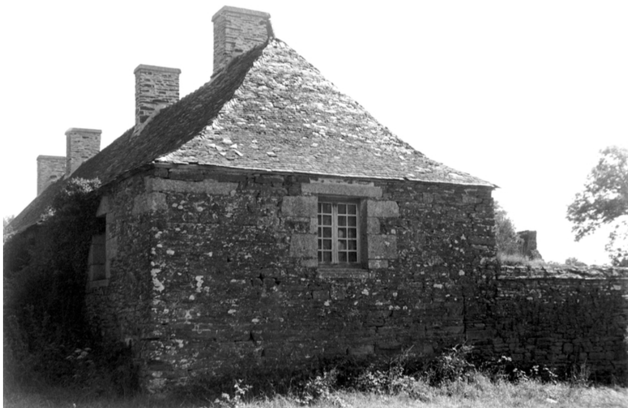
Bâtiment C, pignon sud ouest : vue d'ensemble
