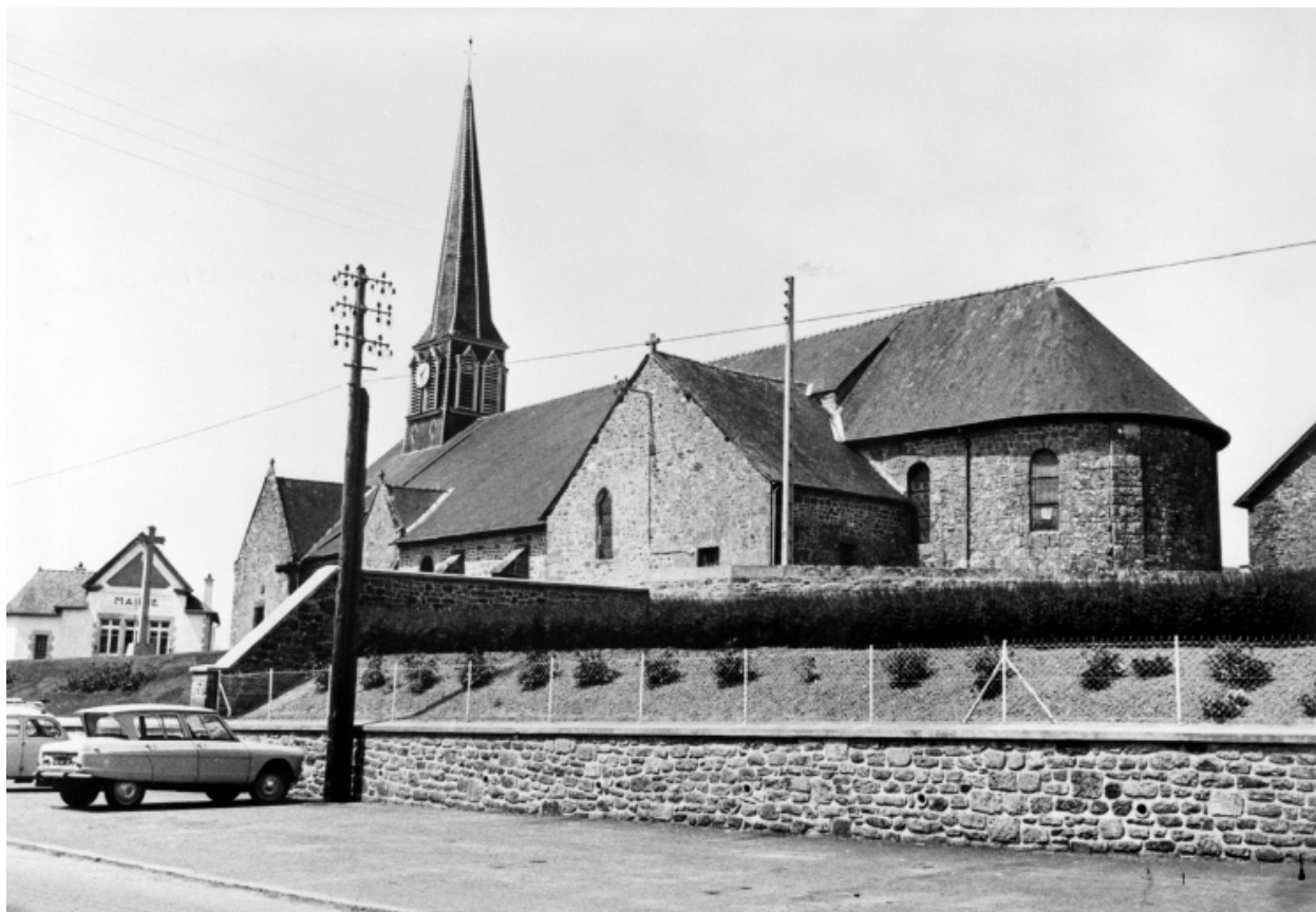
Elévation Sud-Est : vue générale
