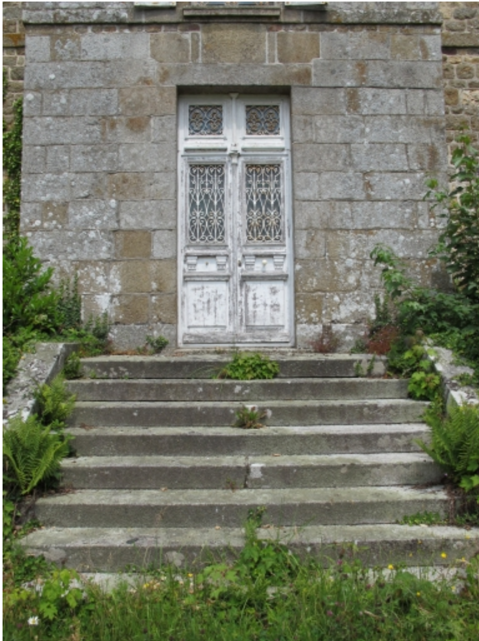
Porte d'entrée principale
