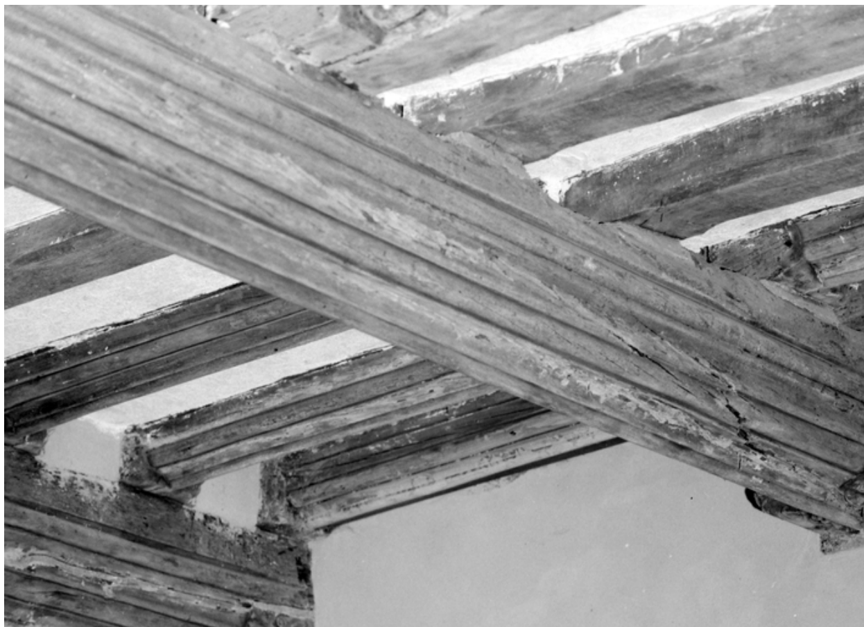
Tour sud, poutres et solives moulurées (état en 1984)
