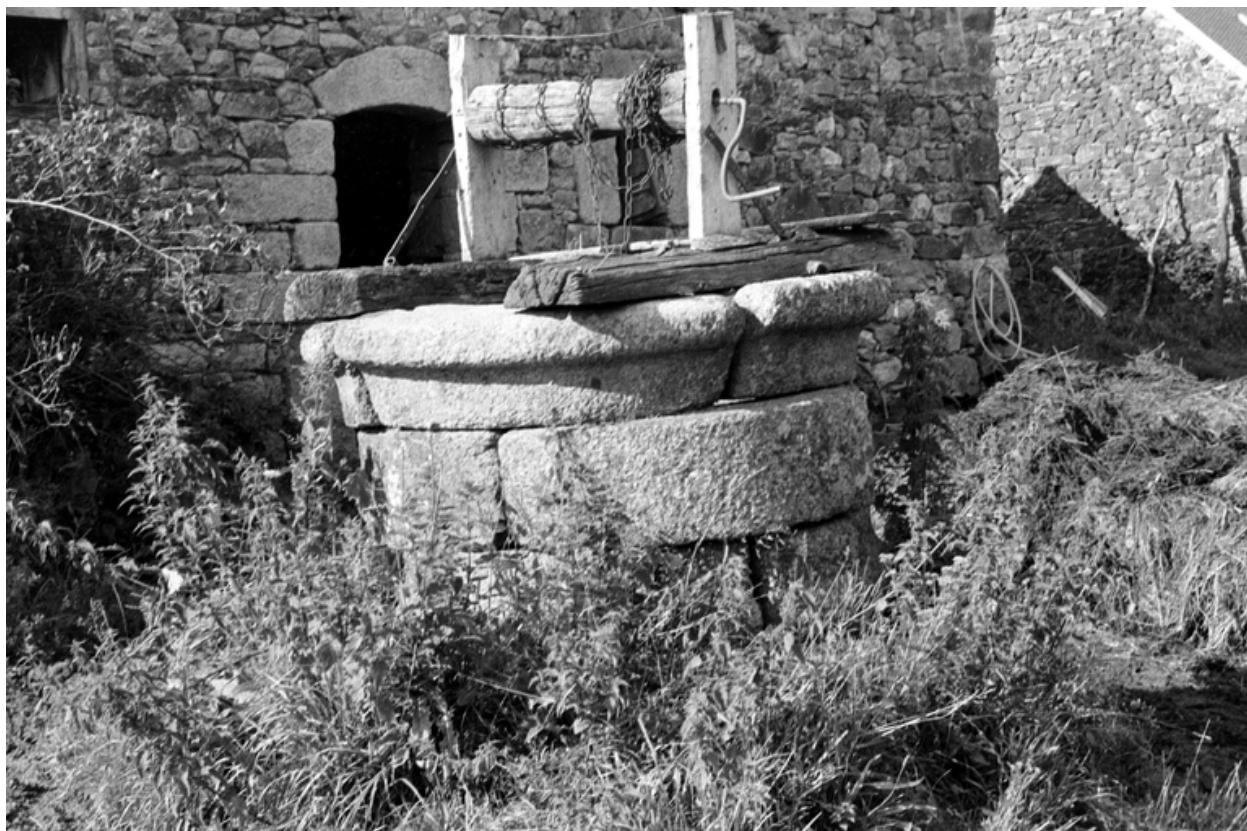
Maison (le château) : vue du puits
