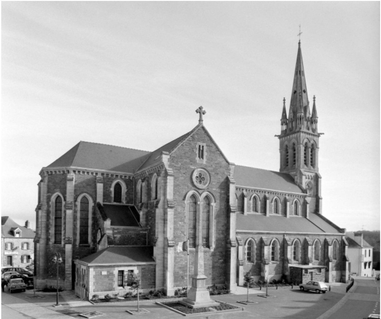
Elévation Ouest : vue générale
