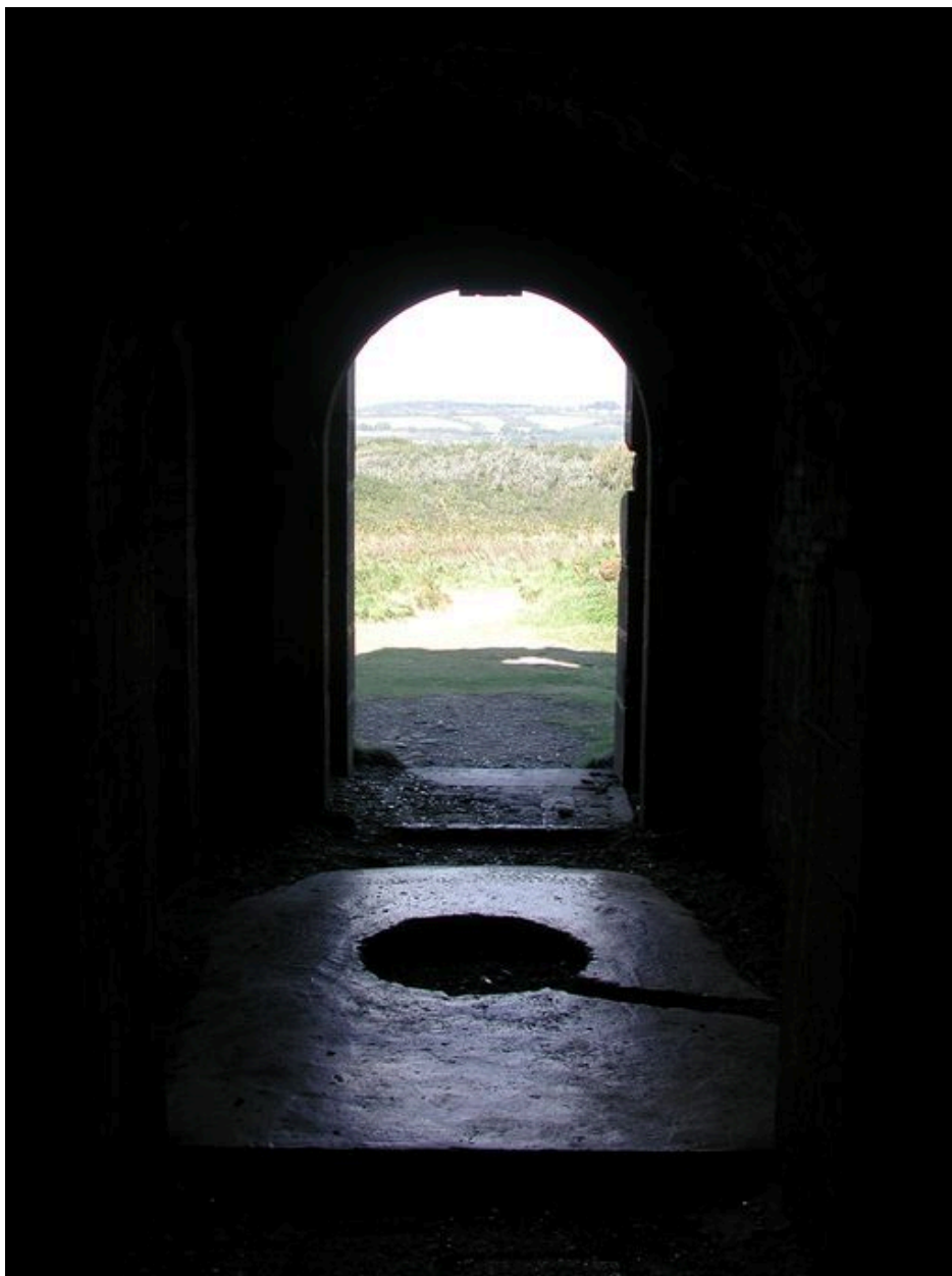
Vue du réduit de batterie de côte de l'île de l'Aber : entrée
