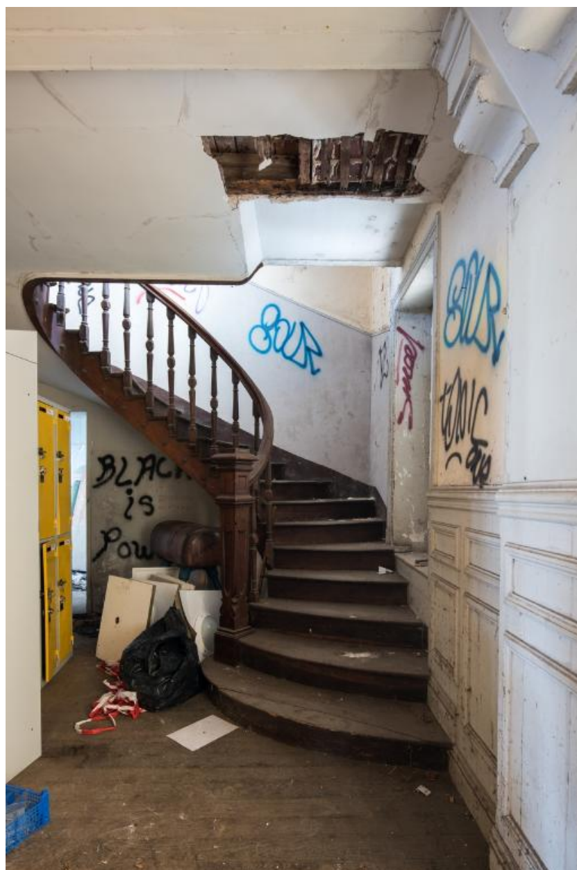
Dégagement et escalier.
