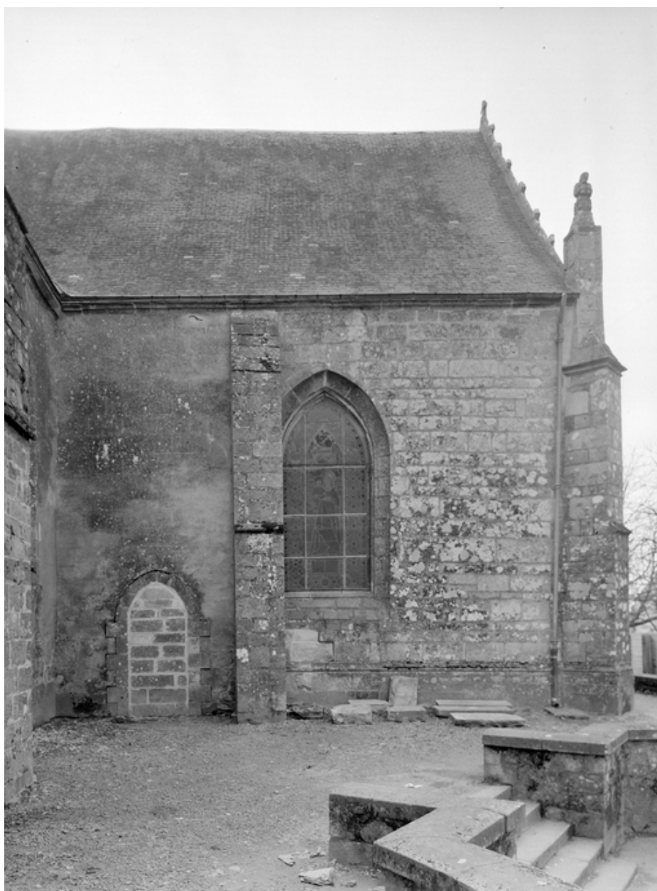
Mur est du bras nord du transept.
