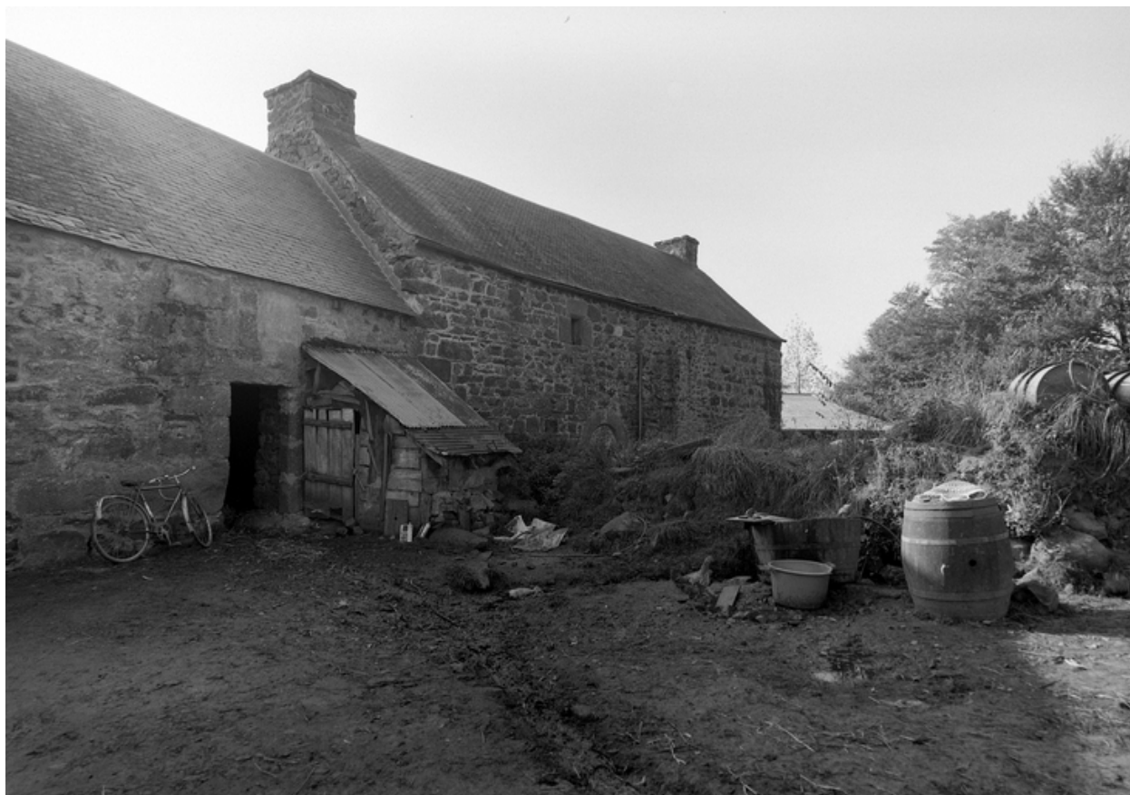
Vue générale de la façade postérieure
