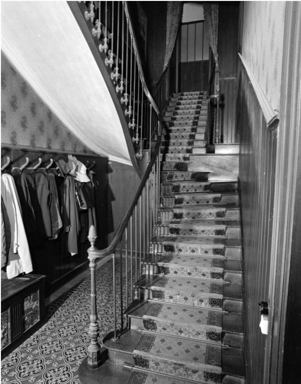
Rez-de-chaussée, escalier de distribution intérieure.
