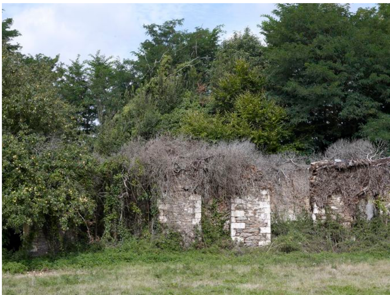
Château : vestiges de construction sur le mur d'enclos du jardin ouest (état en 2010)
