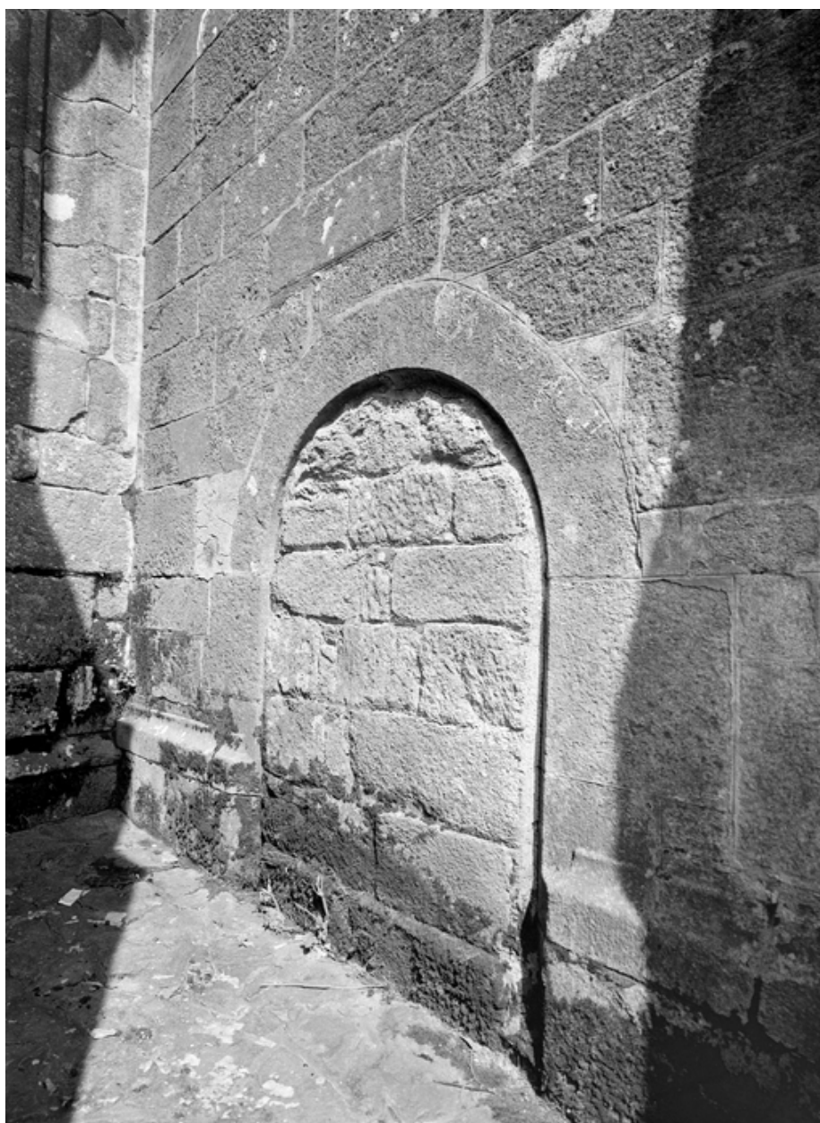
Face ouest du bras sud du transept : porte murée
