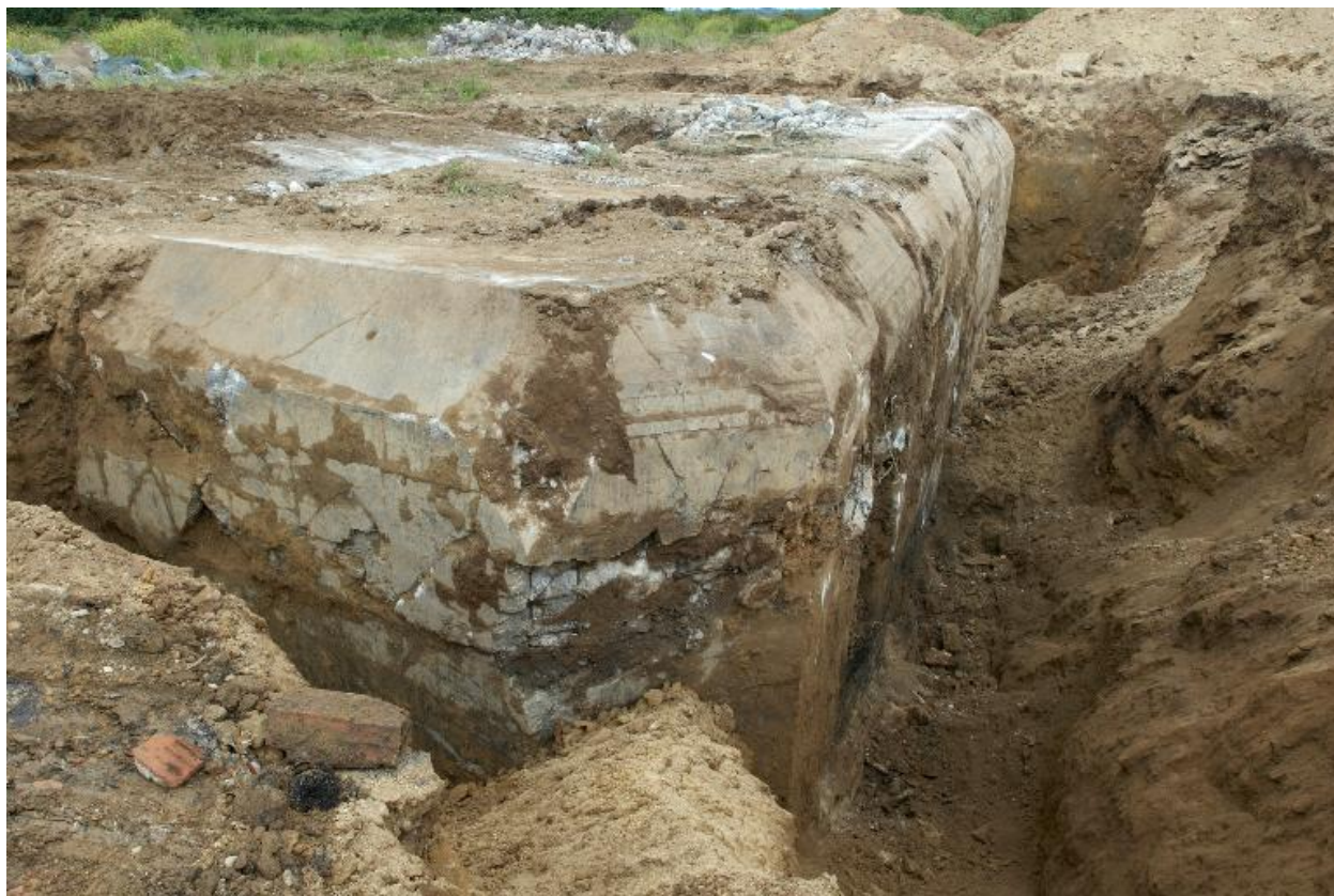
Déconstruction d'un bunker de type 502
