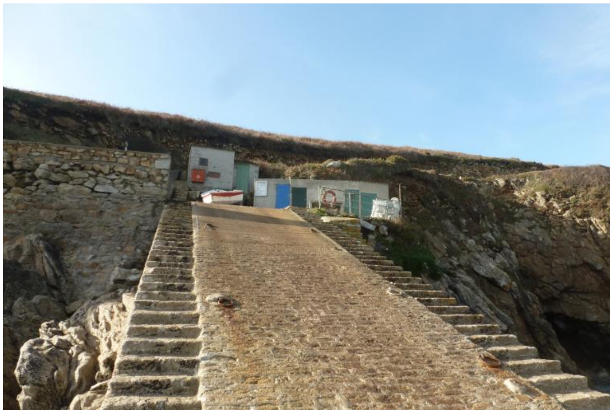
Cale de hissage, vue d'en bas et plateformes avec cabanons.
