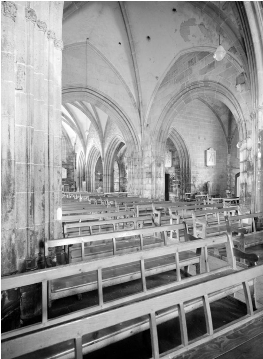
Vue transversale du nord-ouest au sud-est.
