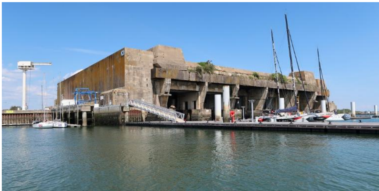
Vue générale du bunker Keroman III depuis le sud-ouest : à droite, l'extension nord-ouest
