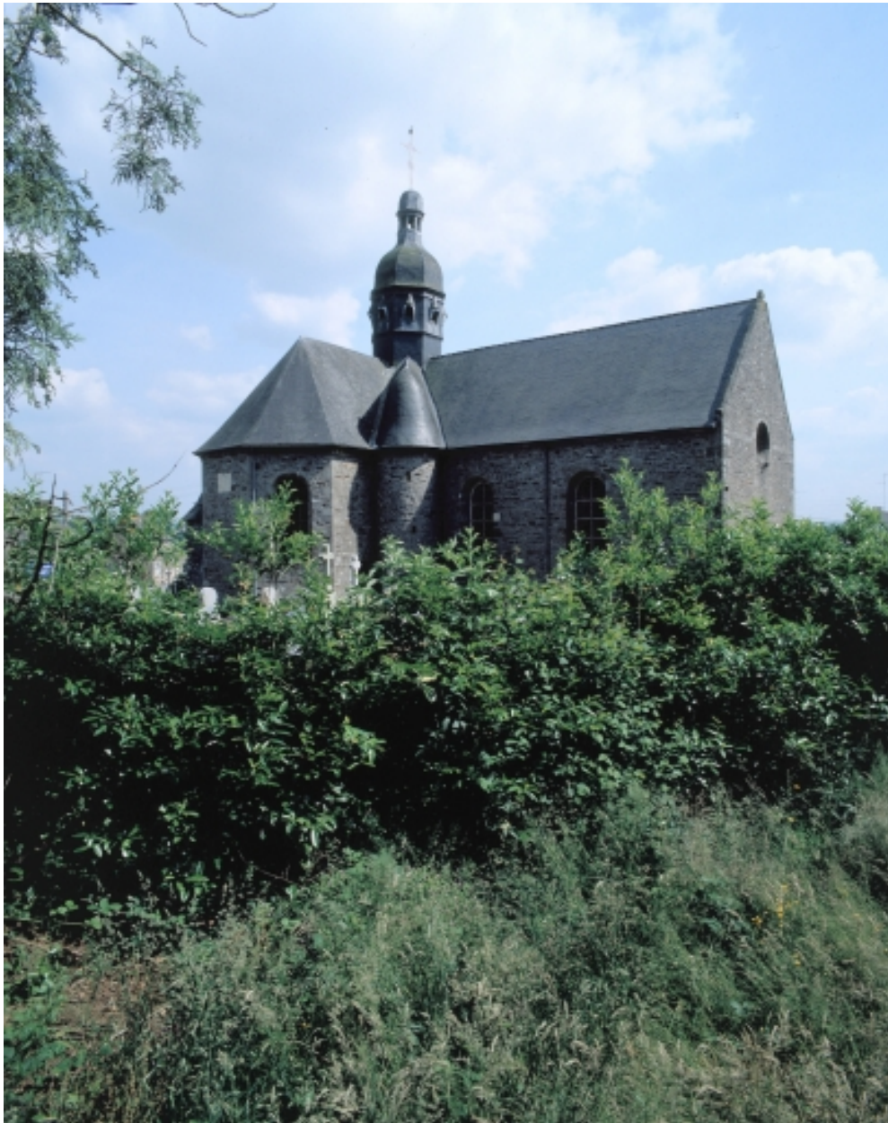
Elévation Nord, partie Est : vue générale
