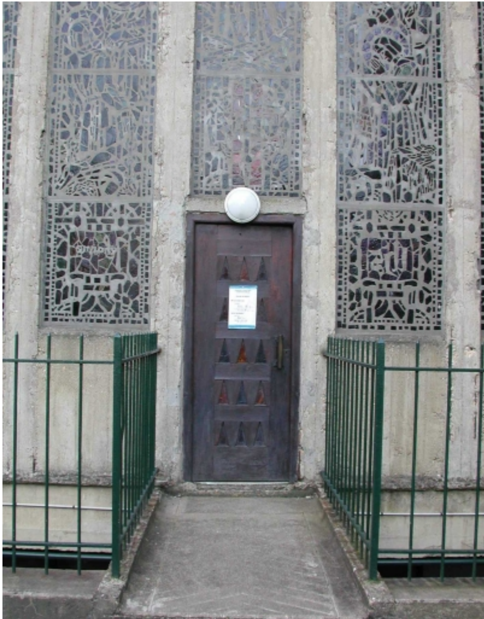
Détail sur la porte ouvrant sur le chœur
