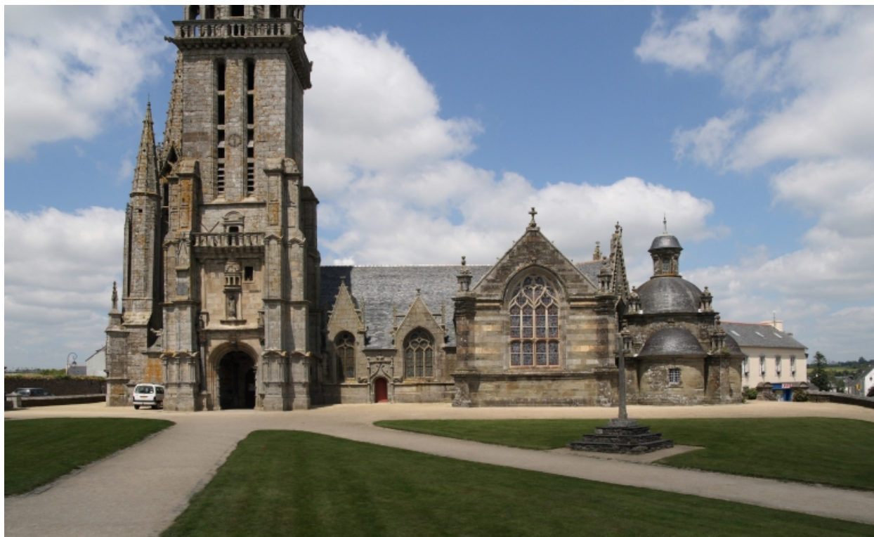
Elévation sud, vue partielle
