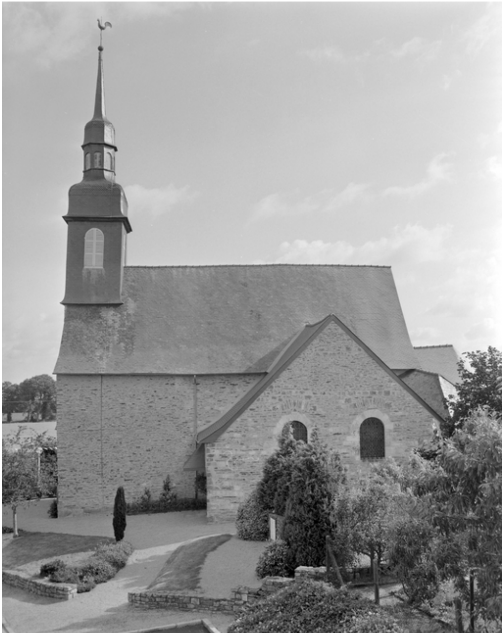
Elévation Sud : vue générale
