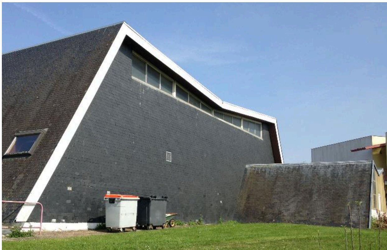
Façade est et extension du gymnase
