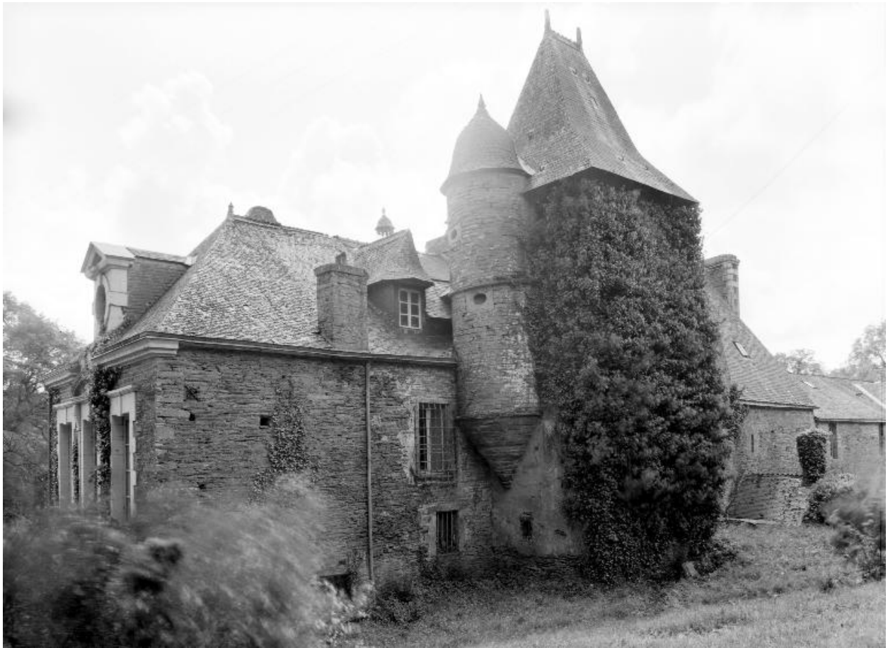
Château, logis, élévation nord : tour d'escalier vue du nord-est (état en 1983)
