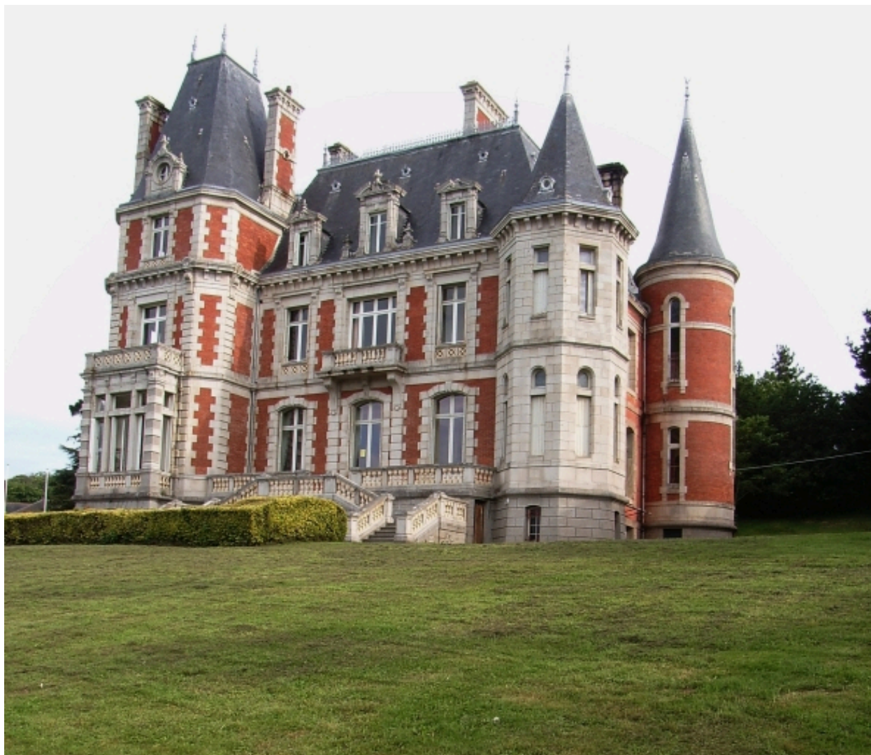
Vue générale (élévation sud)
