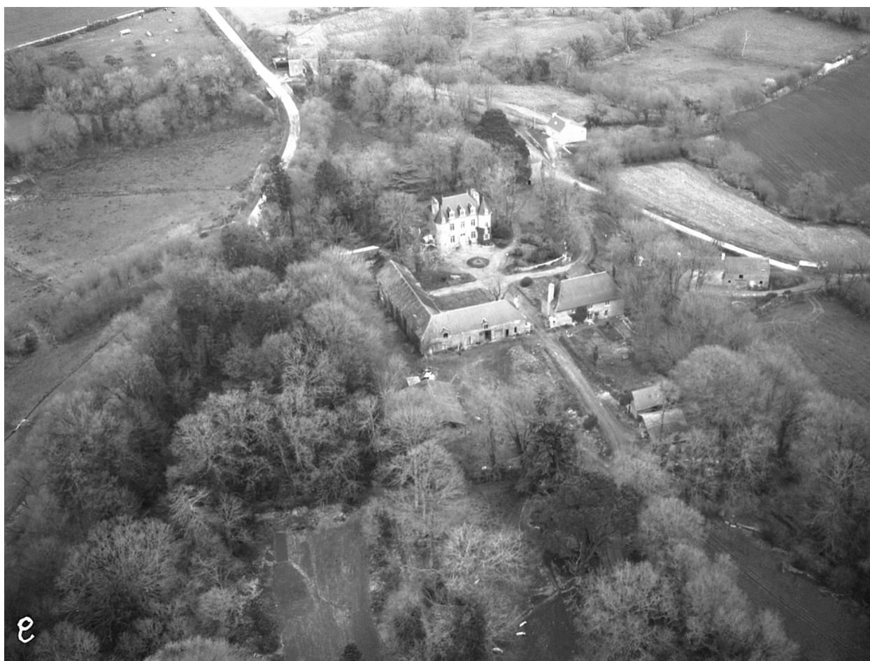
Vue aérienne sud
