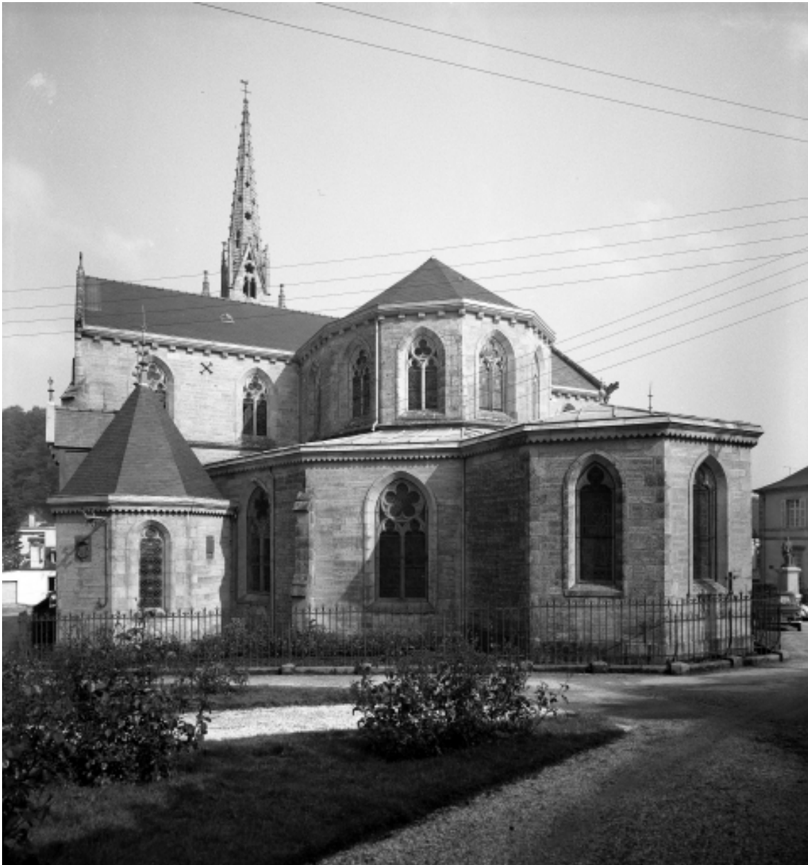
Châteaulin, église paroissiale Saint-Idunet : chevet, vue d'ensemble prise du sud-est, état en 1972
