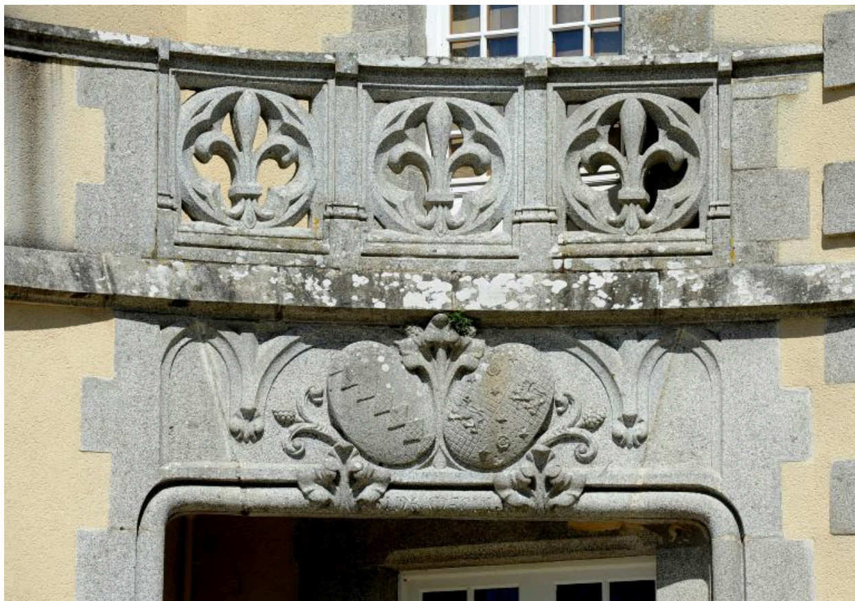
Détail de la porte d'entrée
