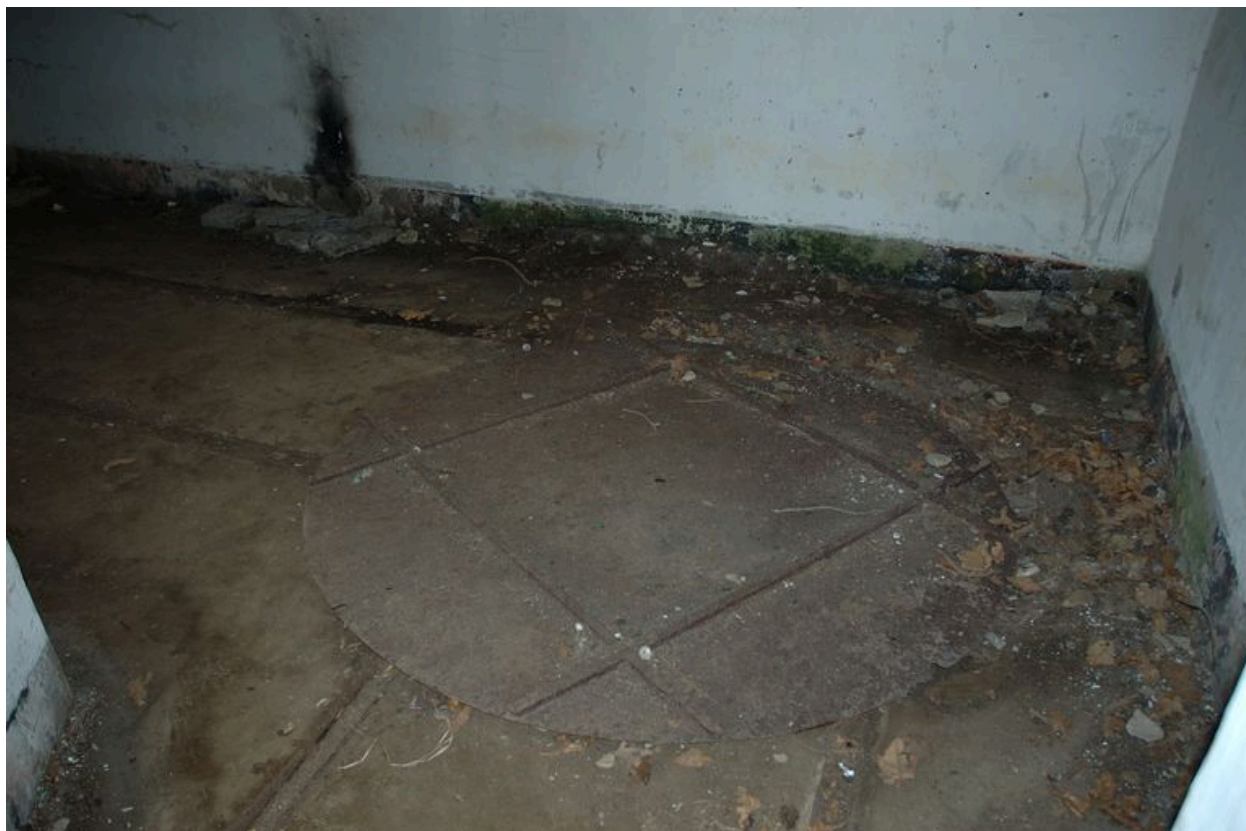
Vue de l'abri pour projecteur de 150 cm du Portzic : intérieur, plaque de translation
