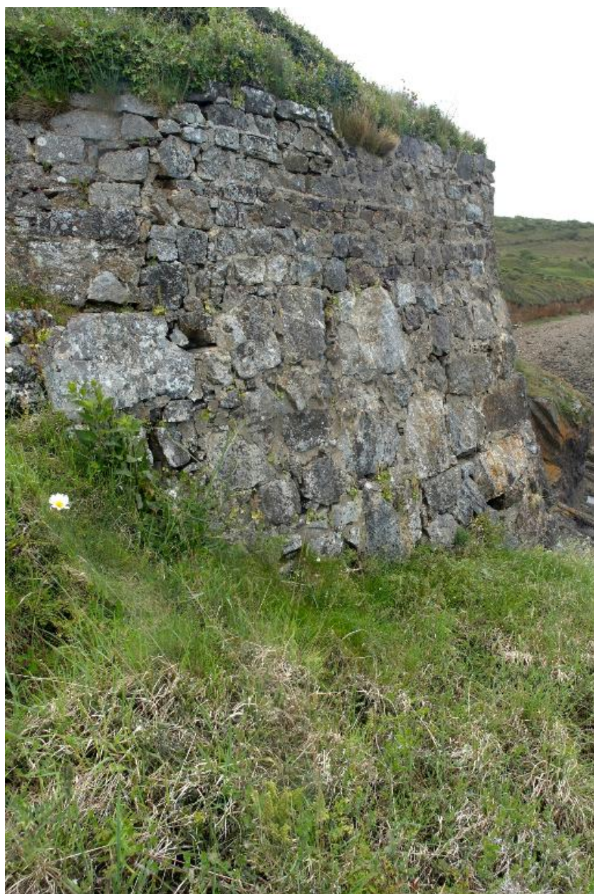
Vue de la batterie basse : mur de soutènement du parapet (état en 2009)
