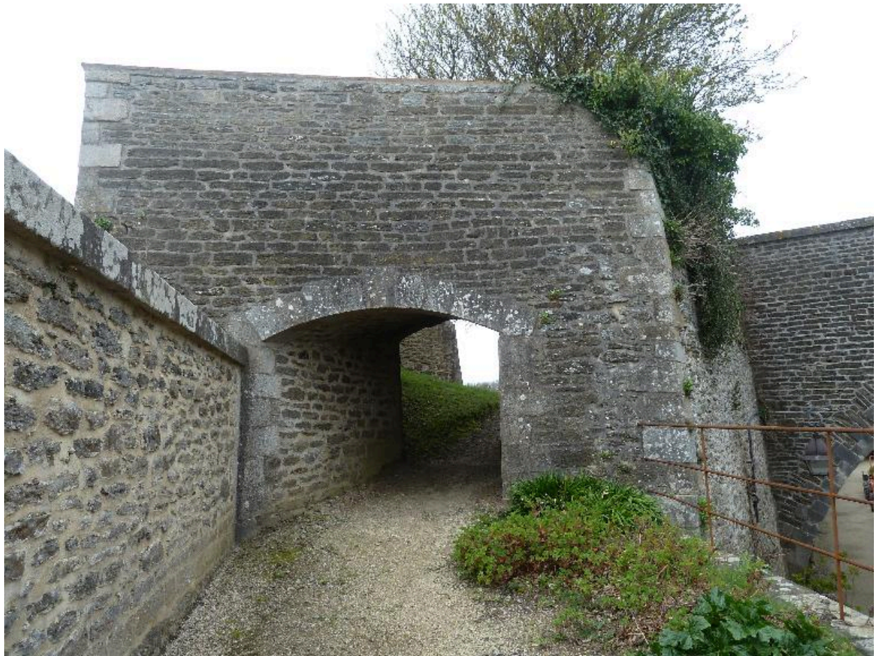
Le Palais, citadelle, cavalier du bastion 2, passage couvert à la gorge de l'ouvrage.
