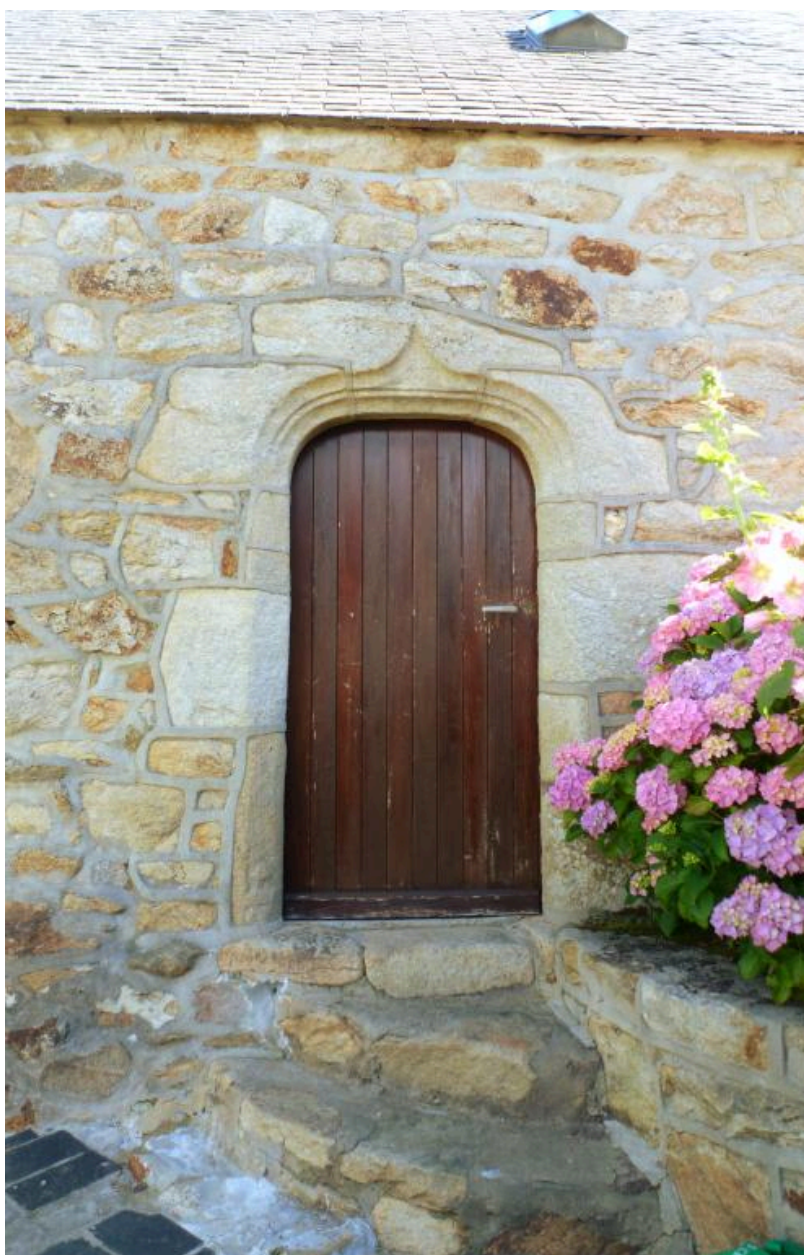
Elévation antérieure du logis, porte d'entrée. (2018)
