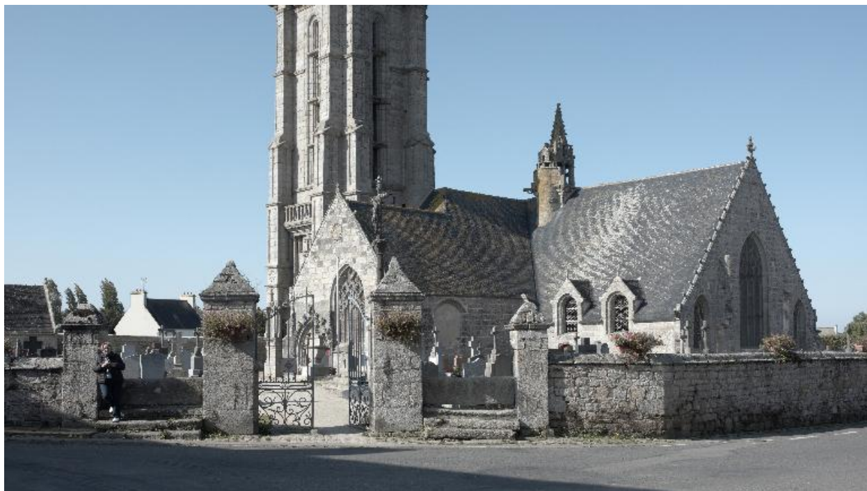
Vue de détail sud-ouest de l'église
