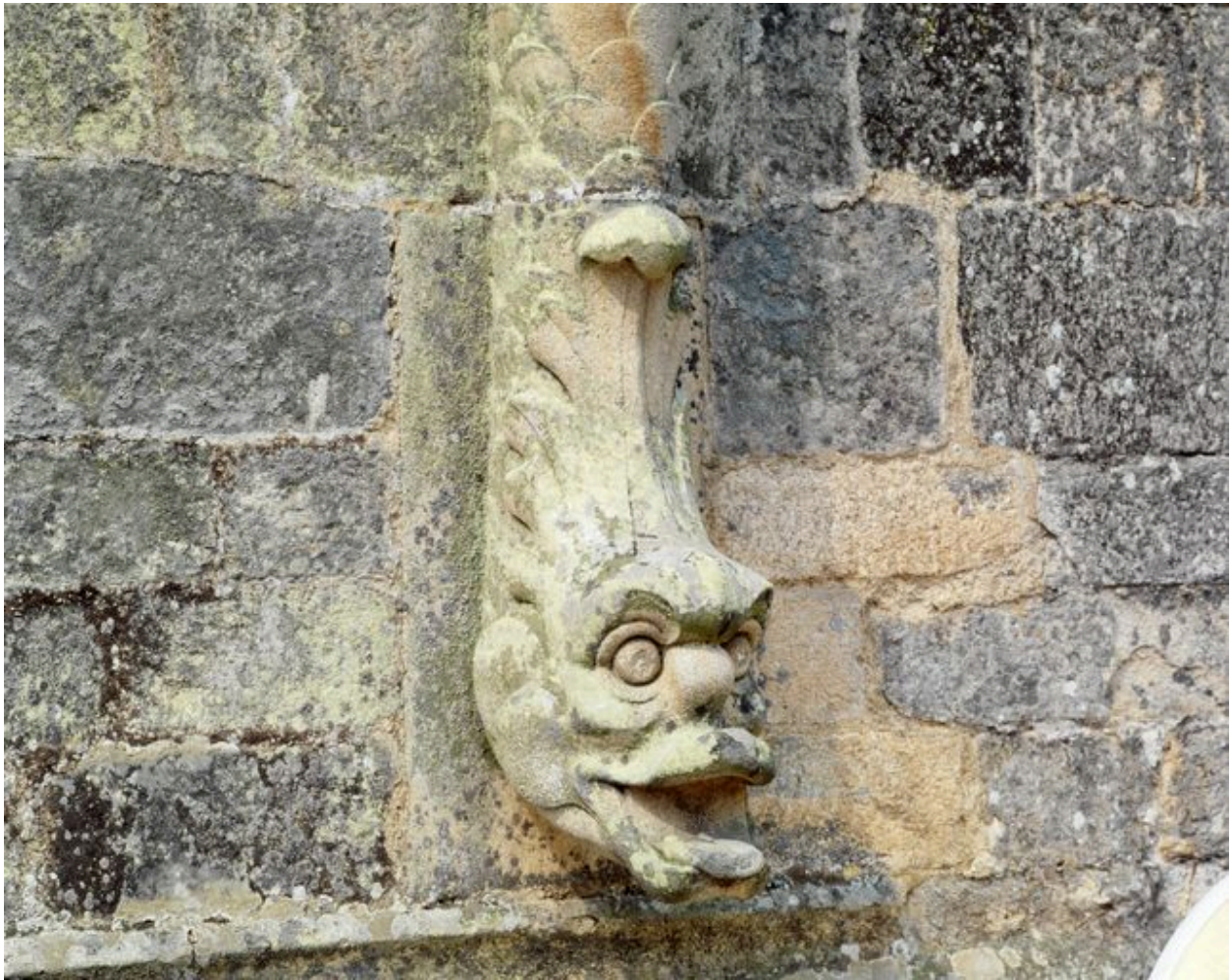
Dauphin d'un tuyau de descente des eaux pluviales : vue générale
