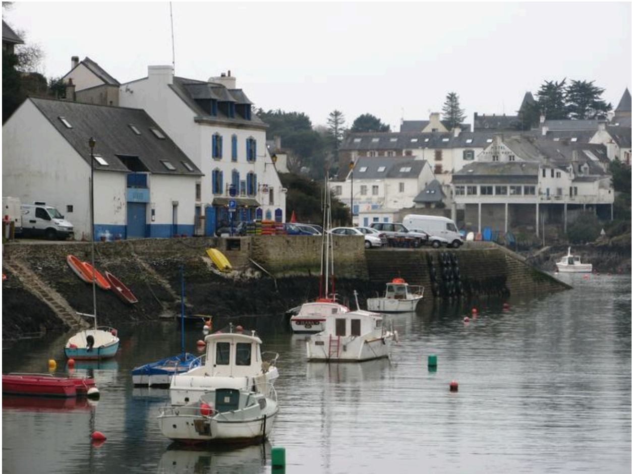
Vue générale de la zone d'activité portuaire artisanale du quai de Kernabat depuis le Vieux Doëlan
