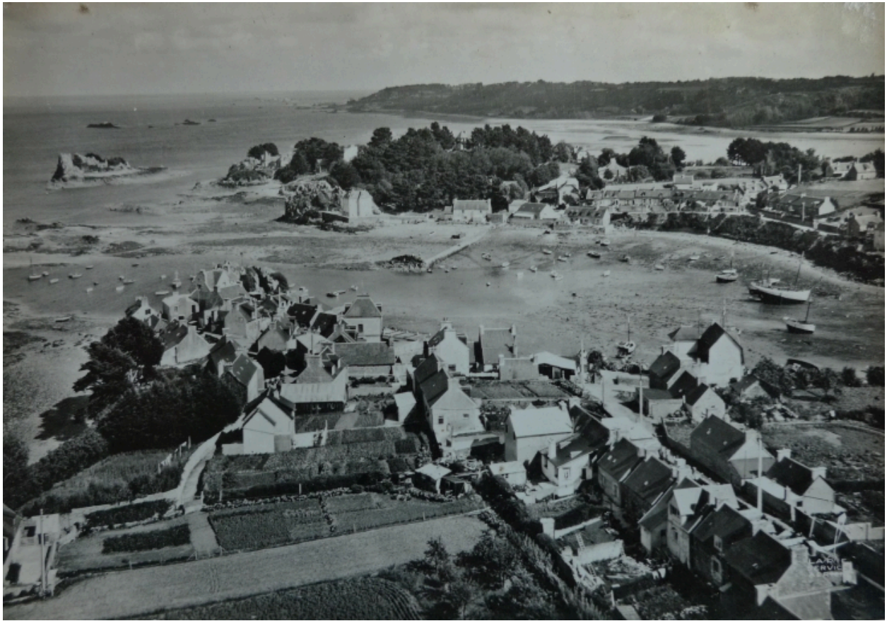
Vue de la partie Sud-Ouest du bourg de Loguivy, vers 1960 : remarquer les terrains cultivés (carte postale, collection particulière)
