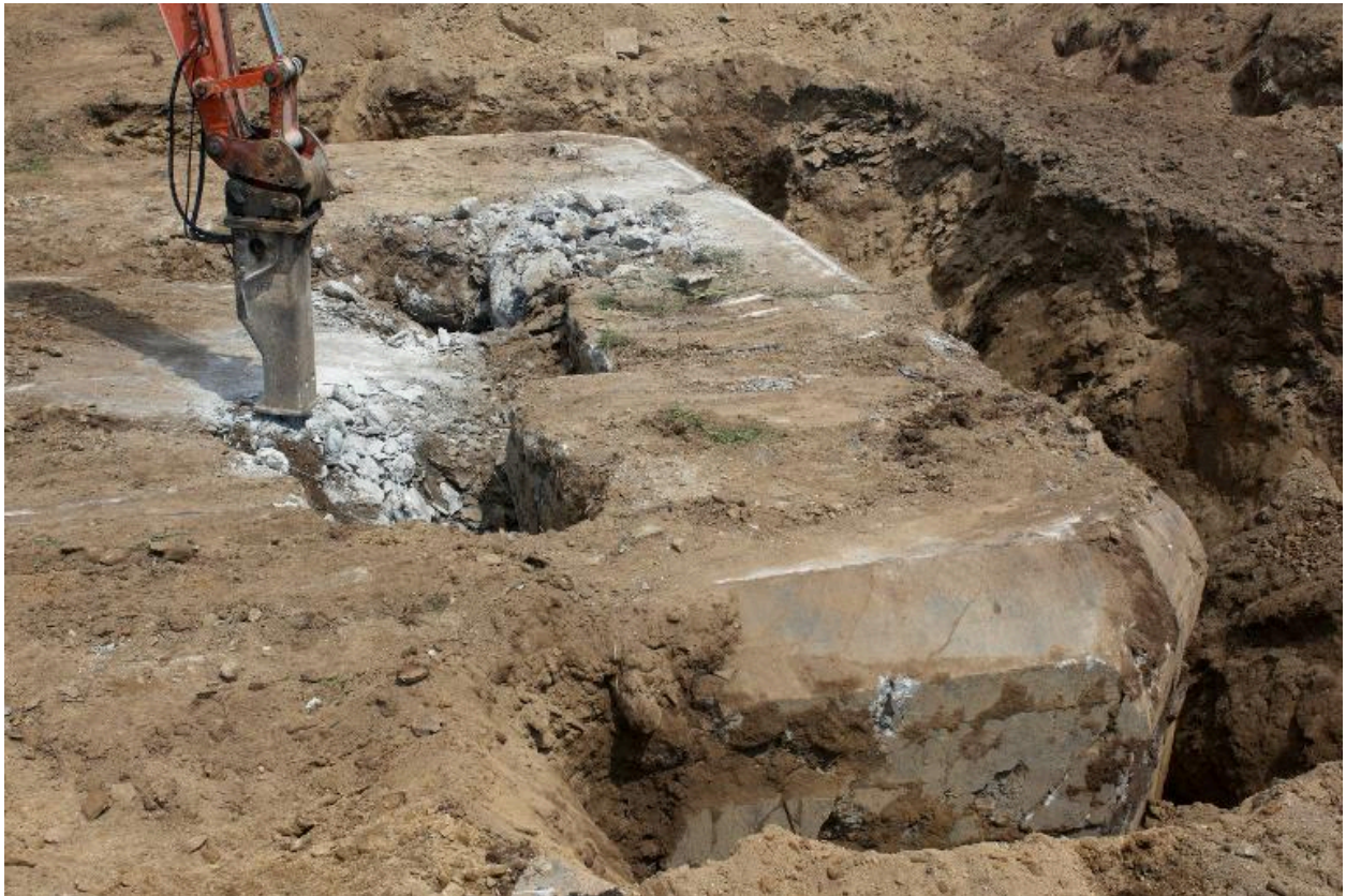
Déconstruction d'un bunker de type 502
