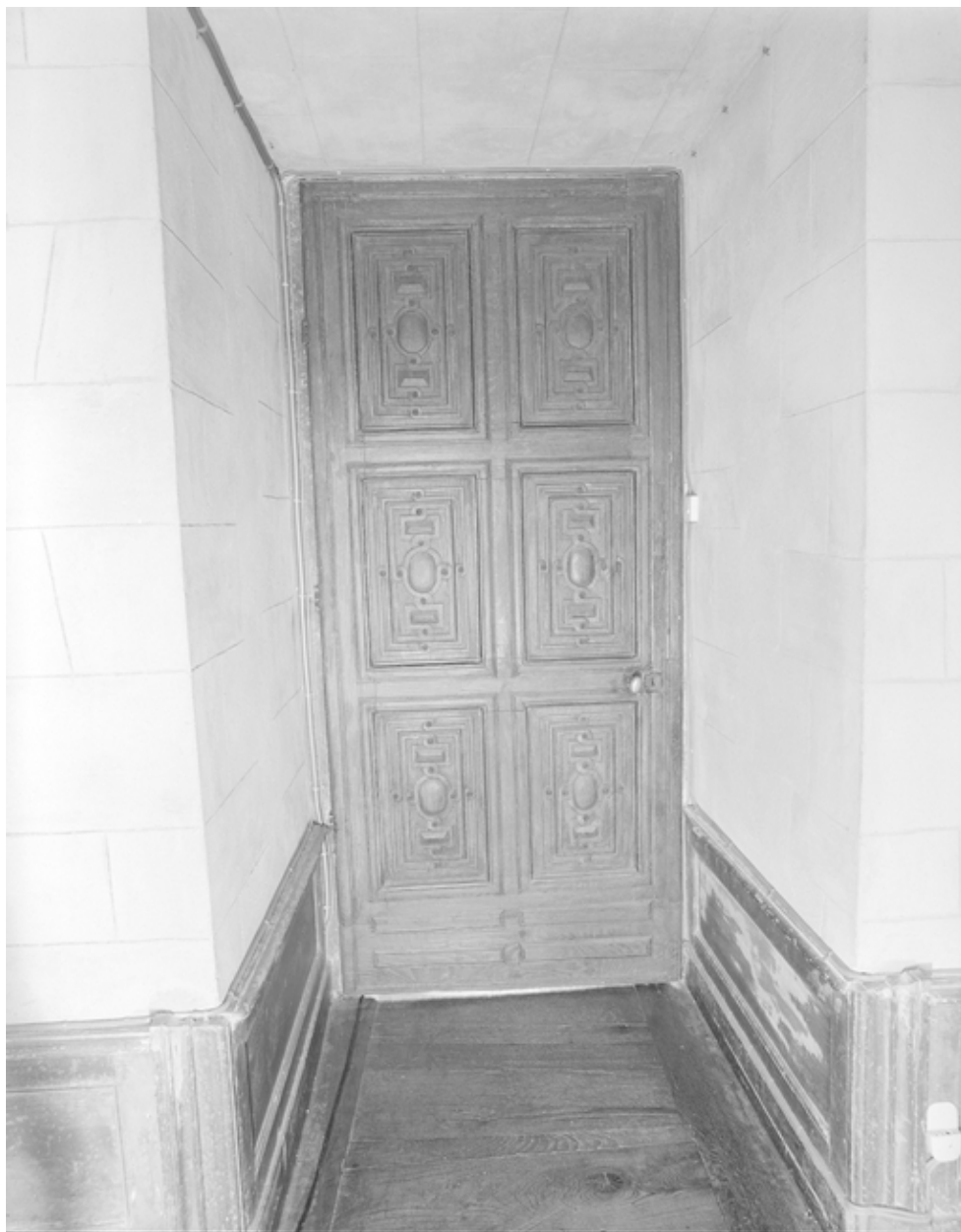
Vue de détail de la porte du couloir.
