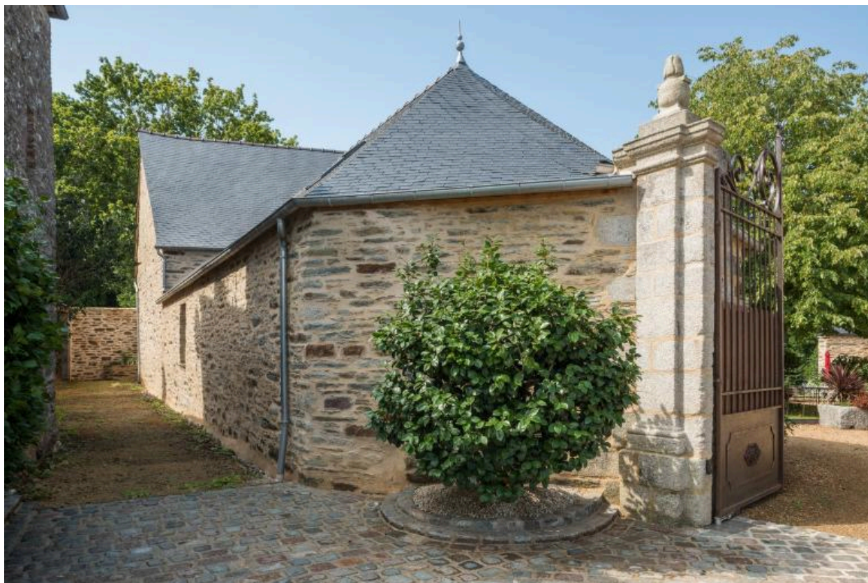
Dépendances au sud de la cour, vue générale sud-est
