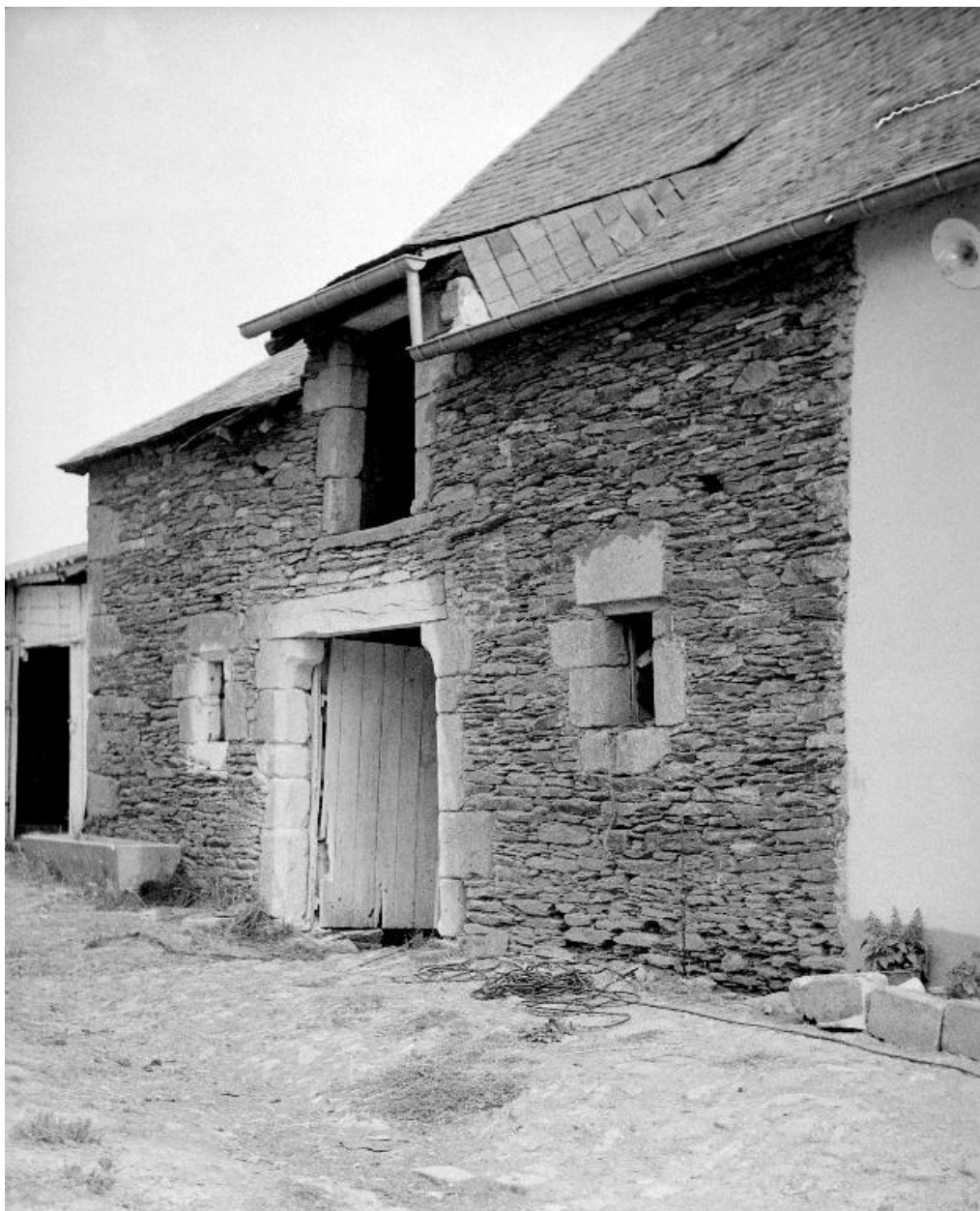
Ferme 17 : la grange (état en 1969)
