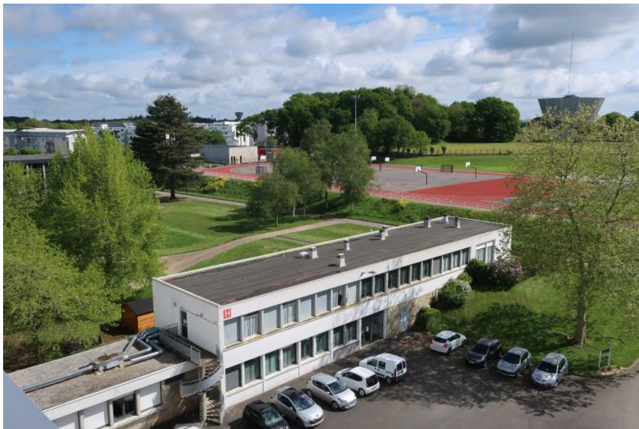
Façade sud de l'infirmerie (H).
