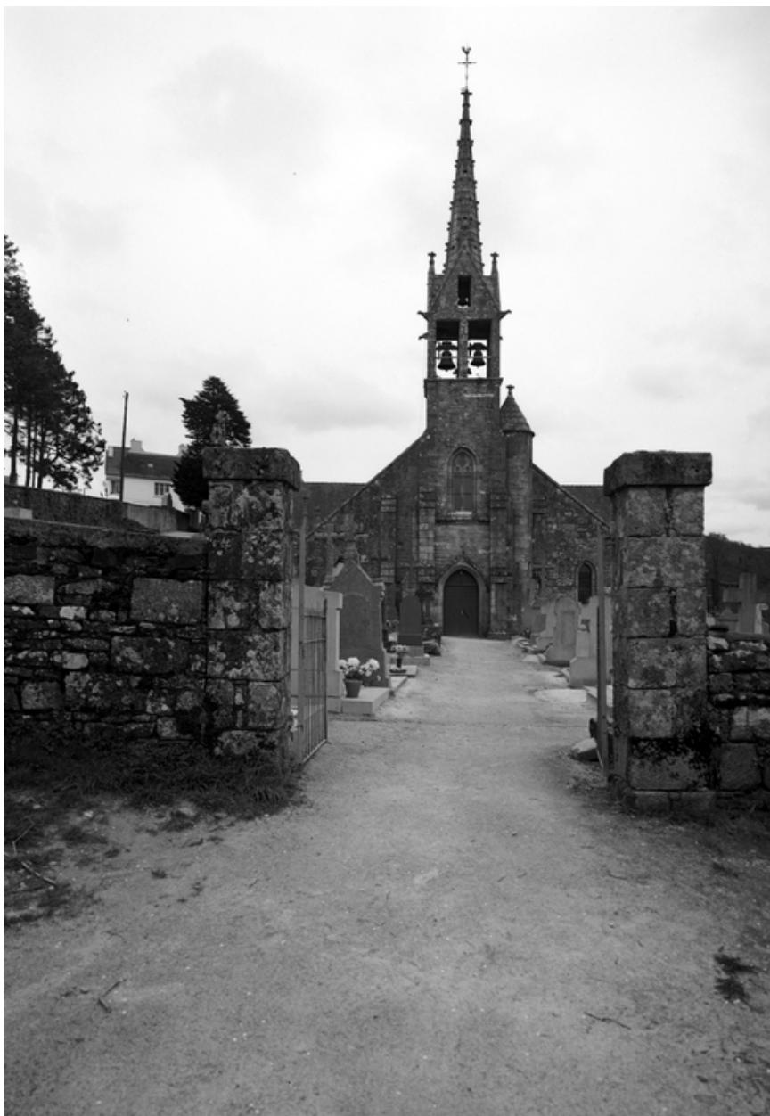
Vue générale façade ouest
