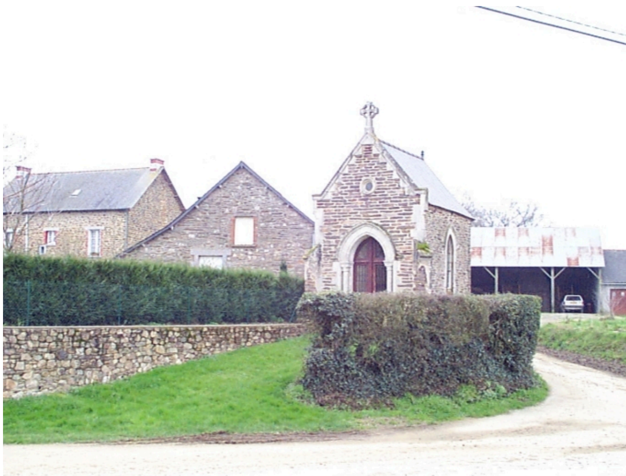
Vue de situation nord
