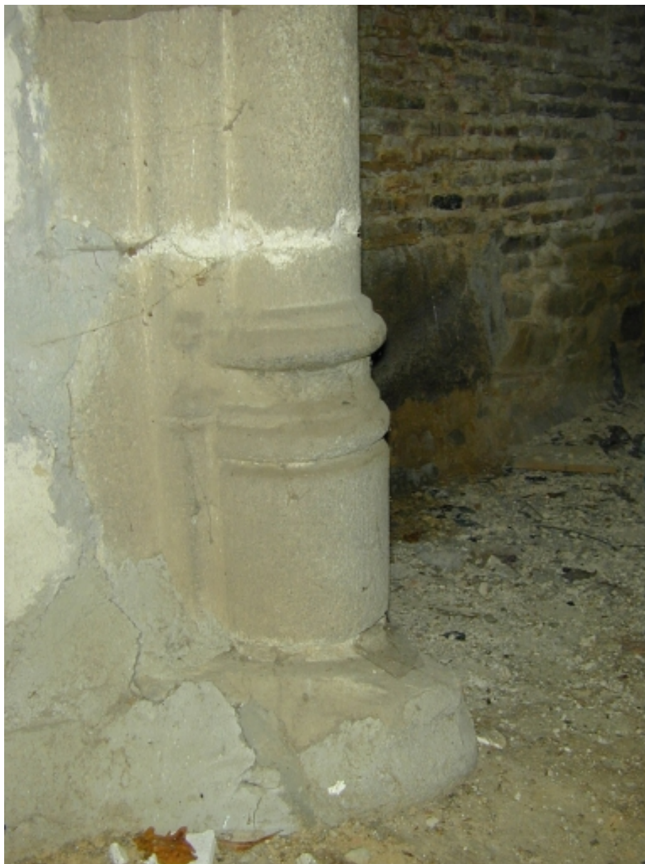
Intérieur, 1er étage, cheminée du 15e siècle : base du piédroit
